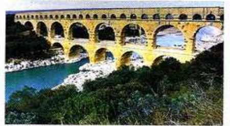
Pont du Gard, aqueduc romain, 1 er siècle apr. J.-C.
