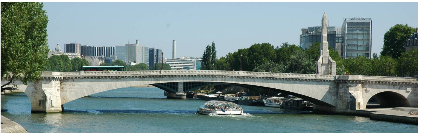
Pont de la Tournelle (Paris), pont en arc encastré d'une longueur totale de 120 m , début de la construction en 1928 et inauguré en 1930.
