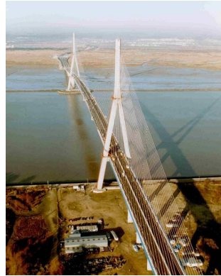
Pont de Normandie, pont à haubans d'une longueur totale de 2141 m, avec une portée centrale de 856 m (1989-1995).
