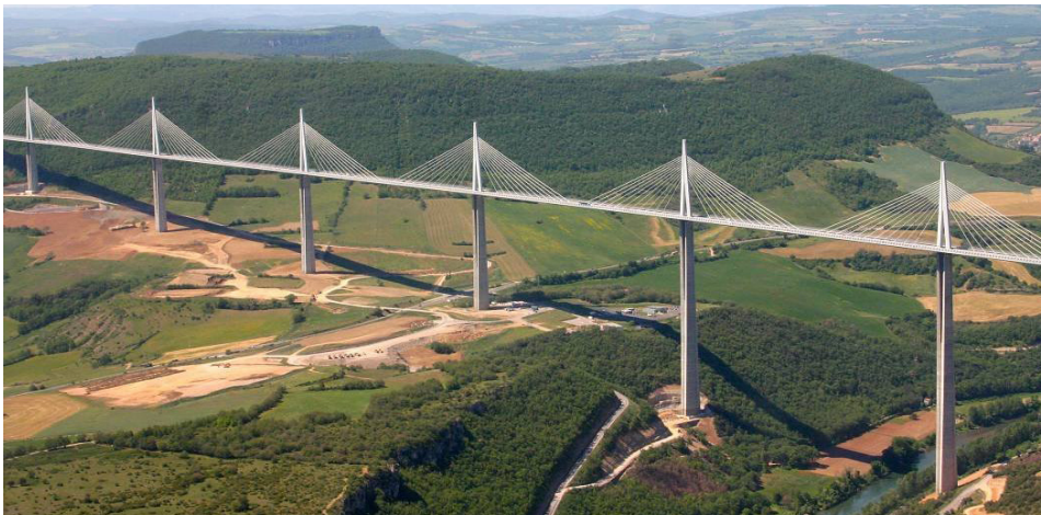
Viaduc de Millau, pont à haubans d'une longueur totale de 2460 m, avec des portées de 204 m et 342 m (2001-2004).
