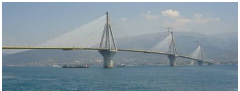
Pont de Rion-Antirion en Grèce, mis en service en 2004, d'une longueur totale de 2880 m, avec des portées de 286 m et 560 m. (1999-2004)
