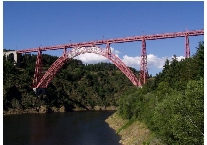
Pont viaduc de Garabit (Cantal), achevé en 1884, avec une portée de 165 mètres.
