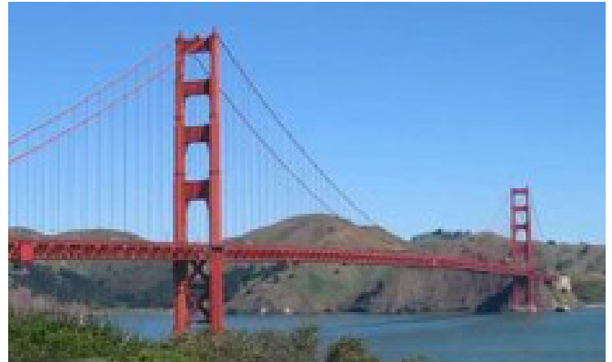
Le Golden Gate Bridge à San Francisco (États-Unis), commencé en 1917 et achevé en 1937 . Il mesure 1 970 m de long, la distance entre les deux tours principales est de 1 280 m et leur hauteur de 230 m au-dessus du niveau de l'eau.
