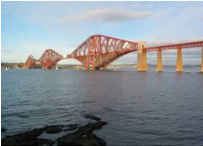
Pont du Firth of Forth (Écosse), réalisé en 1890, avec deux travées de 521 mètres.
