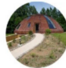
Maison dôme : rotative pour s'adapter à la position du soleil
