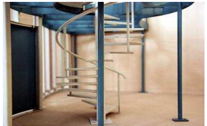
Escalier fait par un métallier-serrurier
